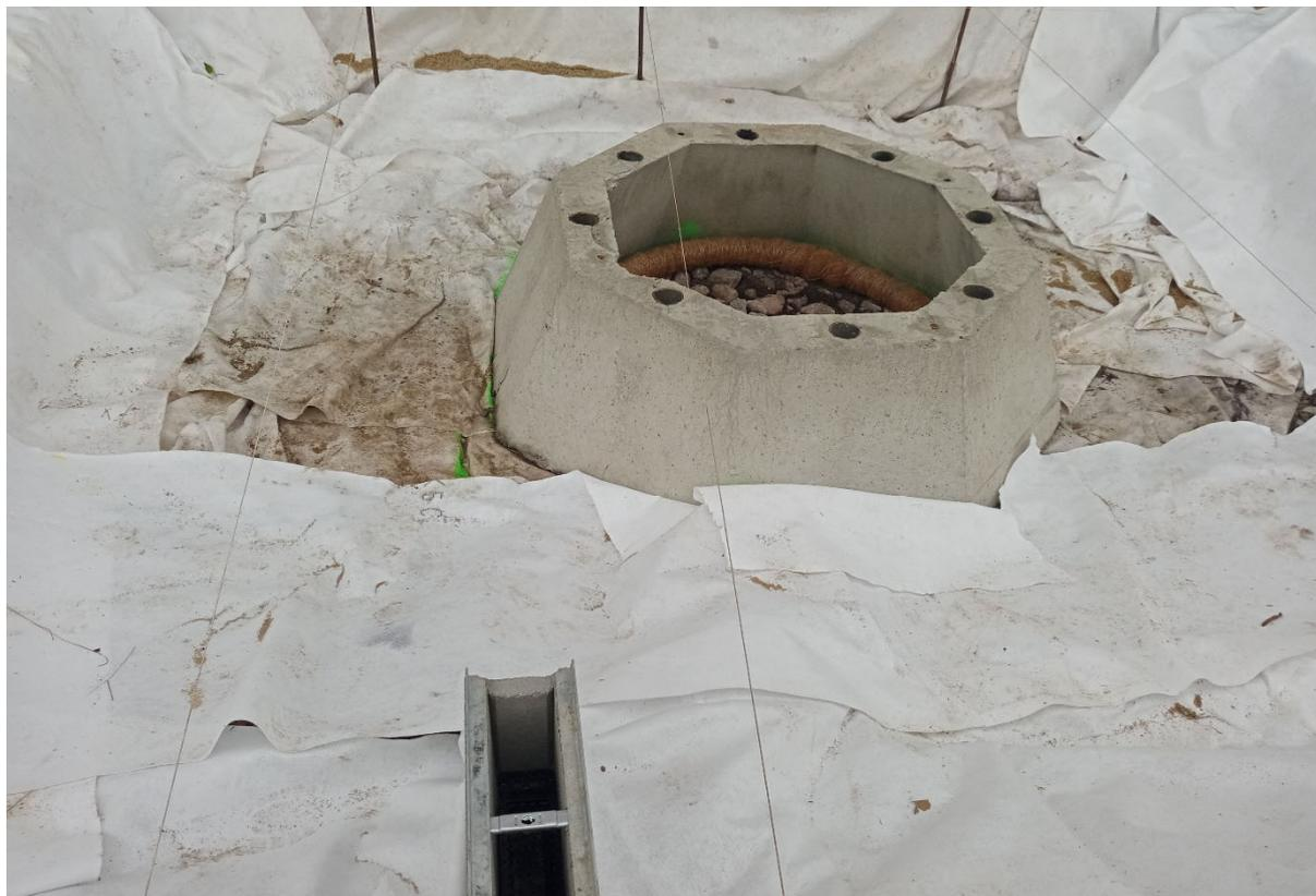
*Sicherung der Einbauschicht mit 3. Lage Schutzvlies*
