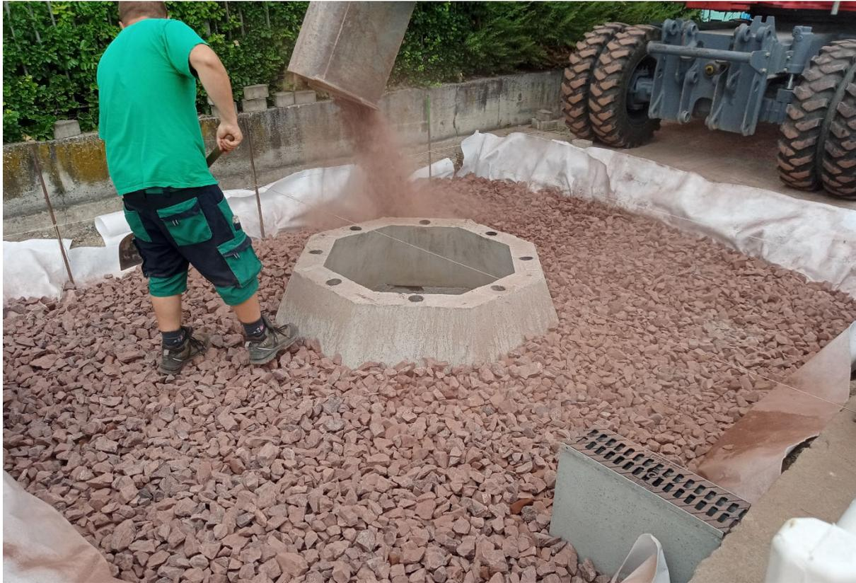
Einbau Belüftungsschicht Schotter 32-56 mm Stärke 23 cm
