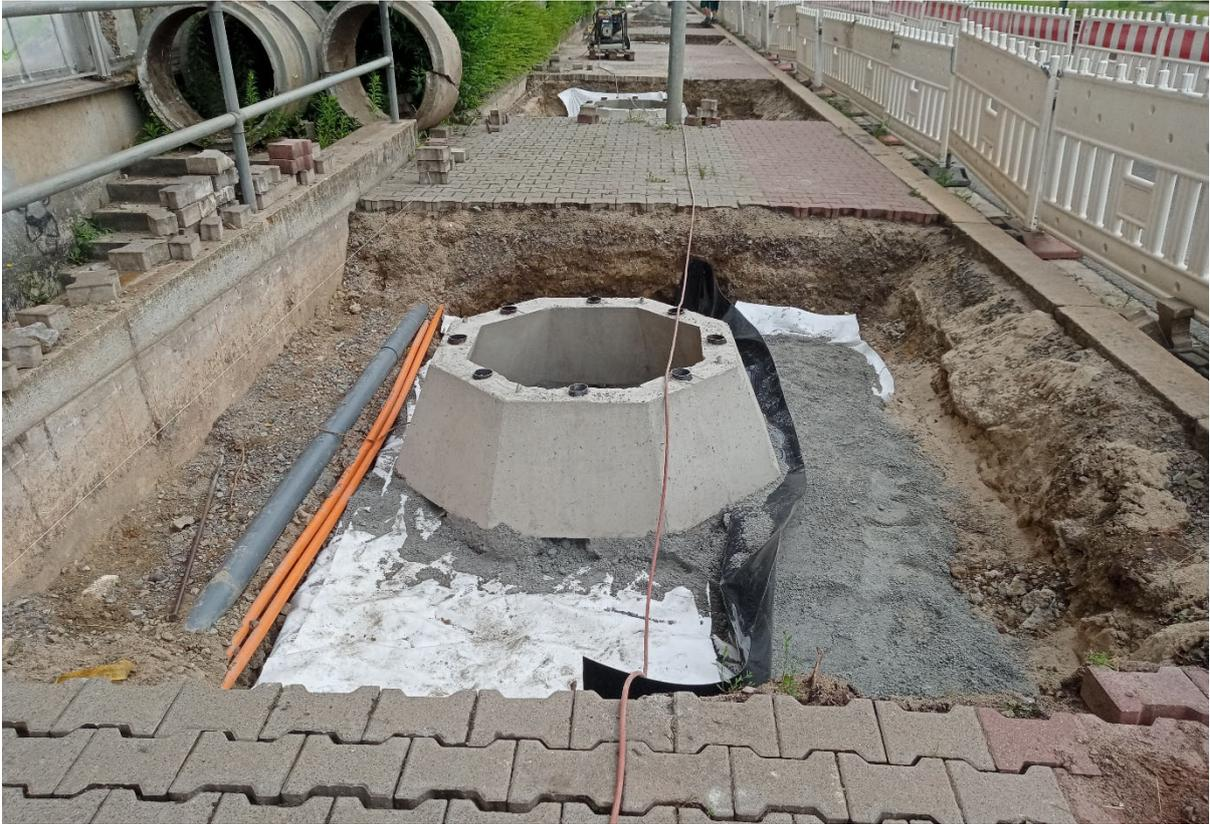
*Fixierung der Leitungsschutzbahn mit Drainbeton Auflegen der Wurzelglocke mit Belüftungsöffnungen*
