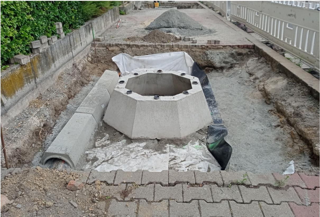
*2Fertigstellen des Leitungsschutzes mit Halbschalen*
