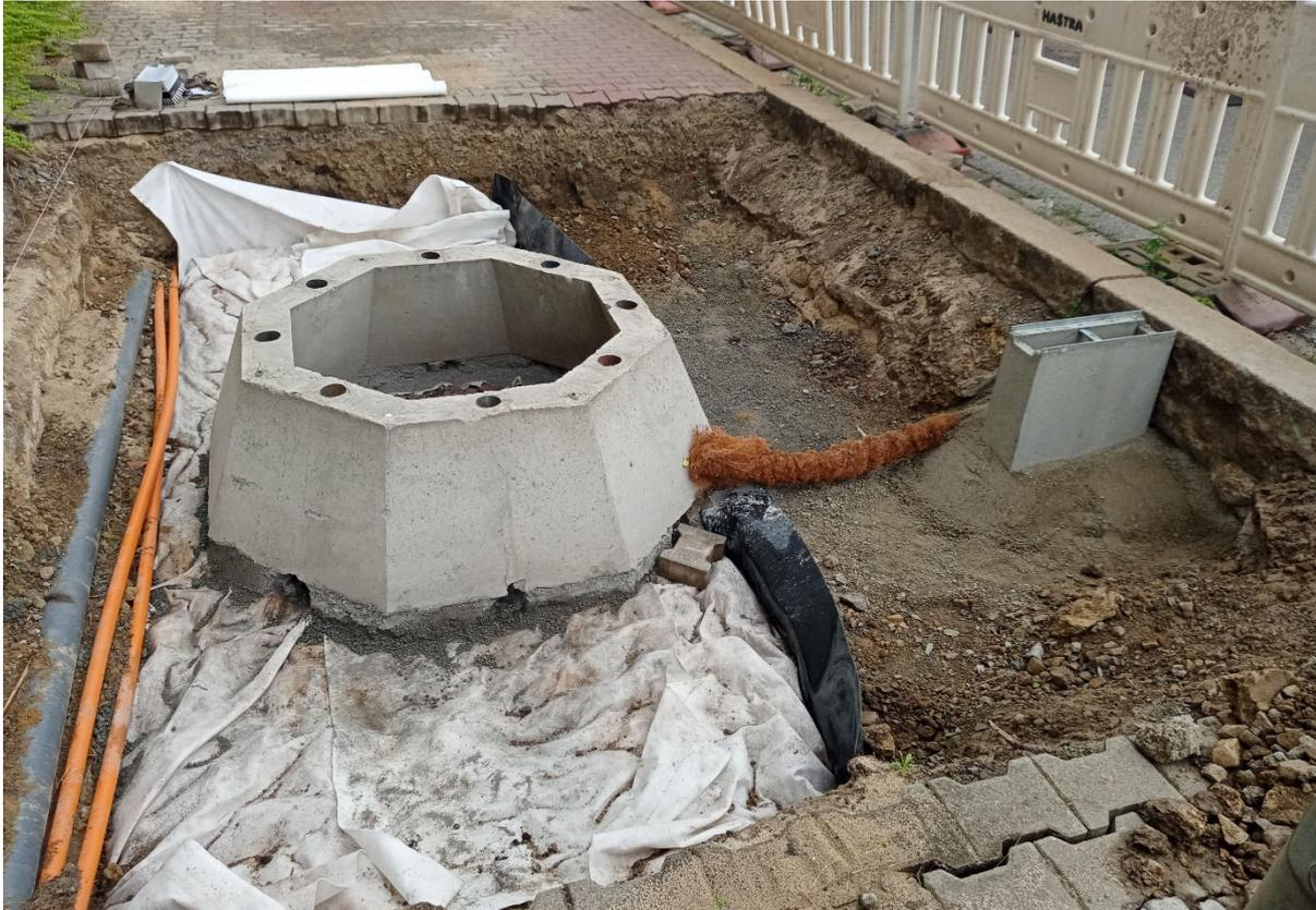
*Herstellung Regenwasseranschluss über geschlossene Aco-Rinne*
