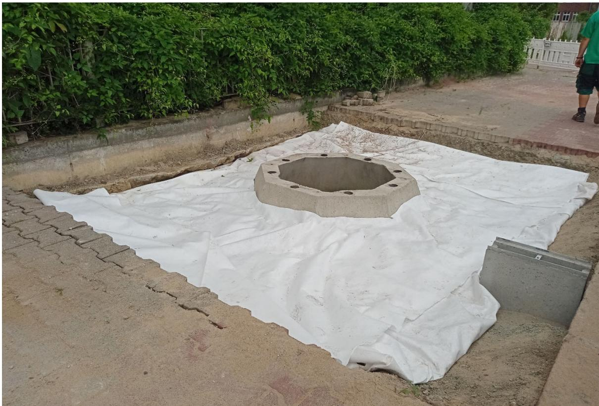
3Letzte Lage Schutzvlies auf der Belüftungsschicht
