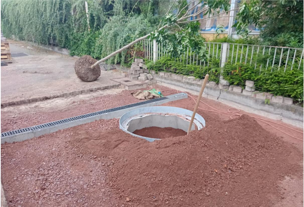
*Verfüllung untere Lage innerhalb der Wurzelglocke mit FLL Baumsustrat überbaubar*
